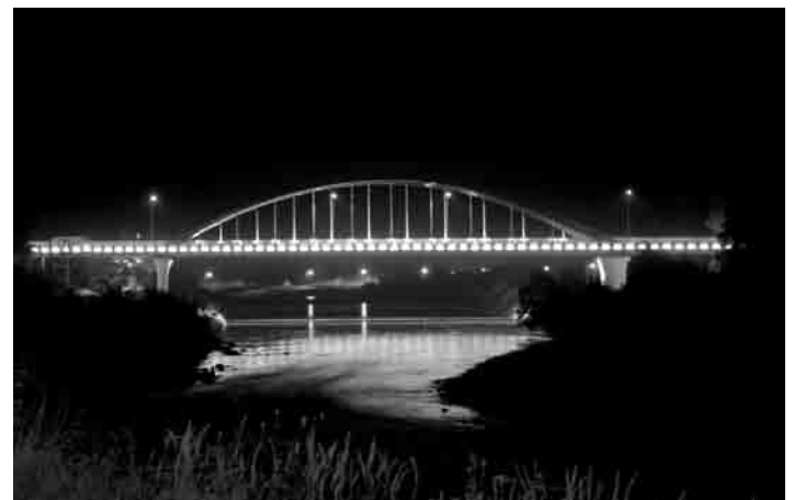
Most drogowy nad Popradem, ul. Krynicka. Jedynie cztery z widocznych lamp na moście służą oświetleniu jezdni i chodnika. Pozostałe oświetlenie to w większości zbyteczne lampy zainstalowane pod mostem, oświetlające rzekę. (AK)
